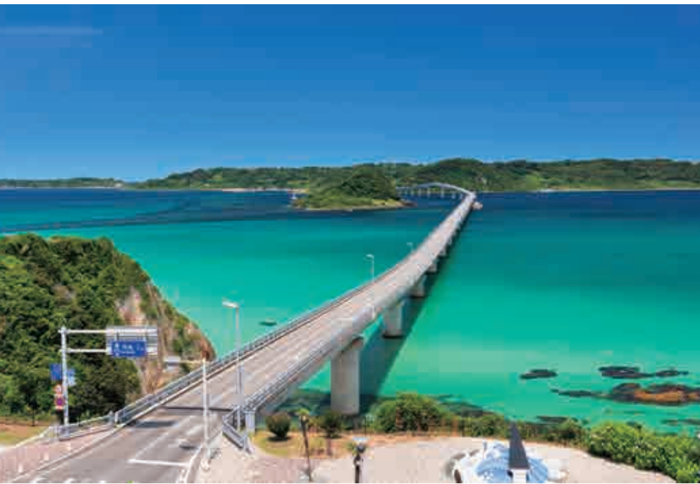
P20上图: 连接山口县离岛和角岛的角岛大桥全长1780m。仿佛径直伸入蔚蓝色大海的大桥景观曾被汽车广告采用,自2000年通车以来吸引了众多游客,成为一处风景绝佳的景点。 P20下图: 架设在鸟取县与岛根县交界处的江岛大桥。为了保证5000吨级的大型船舶能顺利通过,大桥最高处高达45m。因为桥面坡度极大,汽车爬坡不踩到最大油门可能无法通过,所以也被称为“油门满踩坡”。
