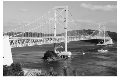
写真—4 大鳴門橋 2013 年撮影
