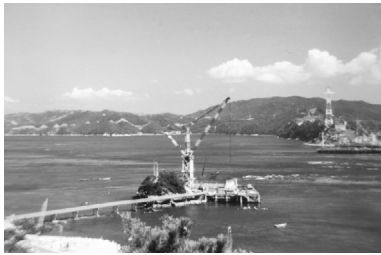
写真—2 大鳴門橋工事中 1980 年撮影
